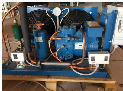
Fig.2: Rack compresseurs / condensateurs
