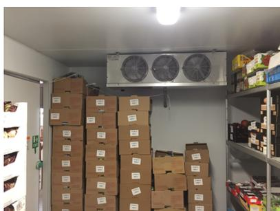
Fig.3: Évaporateurs / intérieur de la chambre froide
