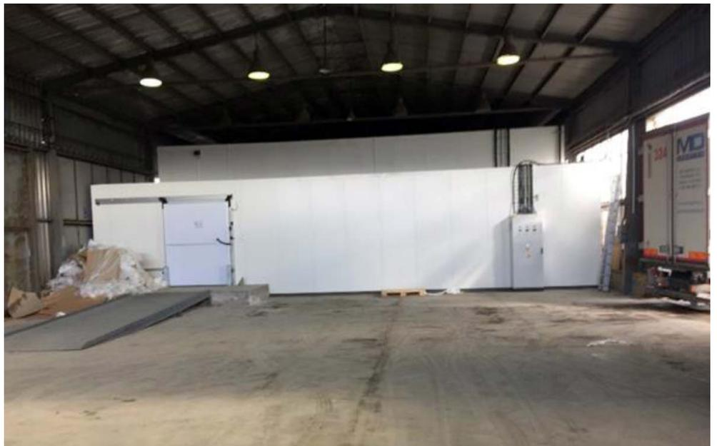
Fig.4: Nouvelle chambre froide construite dans un entrepôt existant
